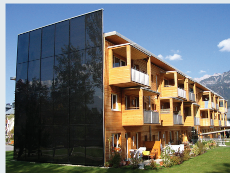
Σπίτι στο Saalfelden, Σάλτσμπουργκ, Αυστρία 101 m 2 μεγάλων συλλεκτών πρόσφυσης FF της TiSUN, εφεδρικά δοχεία 52000 l ήδη στο χώρο, θέρμανση νερού, υποβοήθηση θέρμανσης και πρόσθετη τηλεθέρμανση.
