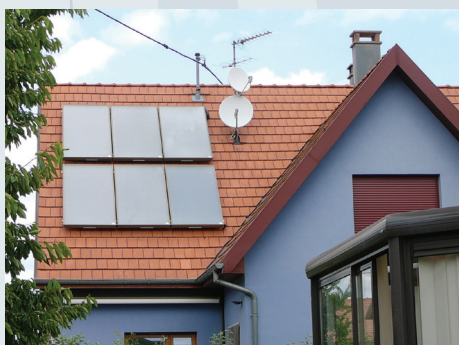
Σπίτι στο Pfaffenheim, Γαλλία 16 m 2 συλλεκτών από τυποποιημένα στοιχεία FM της TiSUN πάνω στην οροφή, 1 ηλιακό δοχείο διαστρωμάτωσης με σφαιρικό εναλλάκτη Pro-Clean 1000 l, θέρμανση νερού, θέρμανση χώρου και πισίνα.
