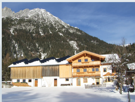
Ξενώνας Barnstatt στο βουνό στο Scheffau, Τιρόλο, Αυστρία 48,40 m 2 συλλεκτών μεγάλης επιφάνειας FA της TiSUN, 1 ηλιακό δοχείο διαστρωμάτωσης με σφαιρικό εναλλάκτη Pro-Clean 2000 l και 1 εφεδρικό δοχείο PSN 12000 l, θέρμανση νερού και υποβοήθηση θέρμανσης, πρόσθετη θέρμανση από ξύλο.
