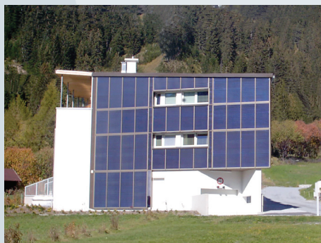
Συγκρότημα σπιτιών St. Anton στο Arlberg, Τιρόλο, Αυστρία 80 m 2 μεγάλων συλλεκτών πρόσφυσης FF της TiSUN, 2 ηλιακά δοχεία διαστρωμάτωσης με σφαιρικό εναλλάκτη Pro-Clean 1000 l και 1 εφεδρικό δοχείο PSN 1000 l, θέρμανση νερού, πρόσθετη θέρμανση από σύστημα θέρμανσης πετρελαίου.
