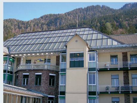
Κρατικό νοσοκομείο Laas στο Kotschach, Karnten, Αυστρία 360 m 2 συλλεκτών μεγάλης επιφάνειας FI της TiSUN σε μεγέθη κατά παραγγελία, 1 ηλιακό δοχείο διαστρωμάτωσης με σφαιρικό εναλλάκτη Pro-Clean 1250 l, θέρμανση νερού και υποβοήθηση θέρμανσης, πρόσθετη θέρμανση από σύστημα θέρμανσης πετρελαίου.
