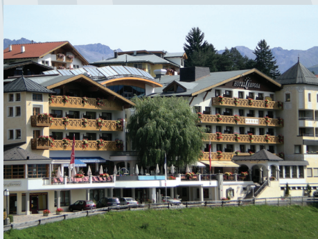
Ξενοδοχείο Cervosa στο Serfaus, Τιρόλο, Αυστρία 75 m 2 συλλεκτών μεγάλης επιφάνειας FA της TiSUN, 3 δοχεία ζεστού νερού 1000 l, θέρμανση νερού και πισίνας, πρόσθετη θέρμανση από σύστημα θέρμανσης πετρελαίου.
