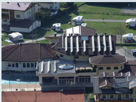
Χώρος κατασκήνωσης Aufenfeld στο Aschau, Τιρόλο, Αυστρία 500 m 2 συλλεκτών μεγάλης επιφάνειας FA της TiSUN, 1 δοχείο ζεστού νερού και εφεδρικό δοχείο, θέρμανση νερού, υποβοήθηση θέρμανσης και θέρμανση πισίνας, πρόσθετη θέρμανση από σύστημα θέρμανσης πετρελαίου
