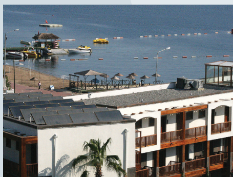
Θερέτρο Olina στο Μπόντρουμ, Τουρκία 56 m 2 συλλεκτών από τυποποιημένα στοιχεία FM, 3 ηλιακά δοχεία διαστρωμάτωσης με σφαιρικούς εναλλάκτες Pro-Clean 1500 l και δοχείο ζεστού νερού BE-SSP 1800 l, θέρμανση νερού και πισίνας.
